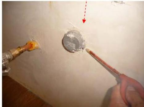
Le prese elettriche non sono sigillate. Anche intorno alla tubazione idraulica entra aria in cucina.
