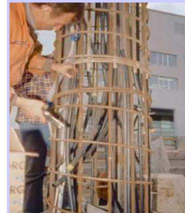
Pali in cemento centrifugo: i tubi sono inseriti successivamente nella cava e poi annegati in cemento o bentonite; i pali hanno un diametro di circa  $0.4 \div 1.5$  m (distanze minime anche meno di 1 m e lunghezza da pochi metri a  $25 \div 30$  m) e possono dare da 30 a 50 W/m di energia termica
