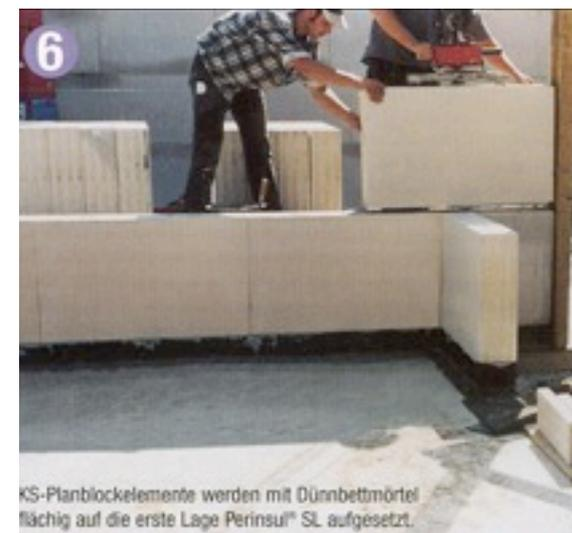
Modalità di messa in opera del blocco isolante perimetrale.
